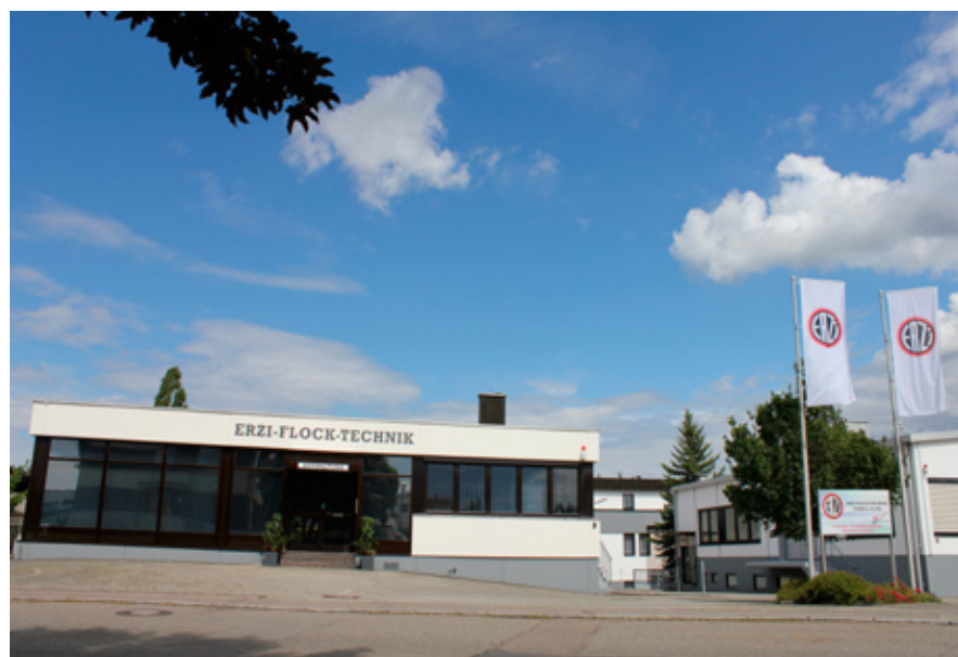
Frontansicht mit Gebäude Verwaltung, Beflockung, Kunststoffverarbeitung Formenbau im Hintergrund - nicht zu sehen.
